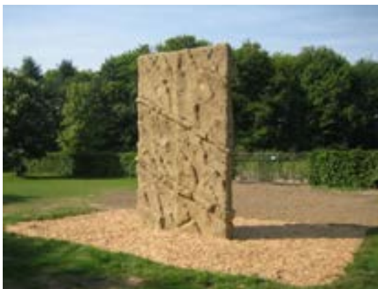
5 m hohe Kletterwand Herzogenrath
