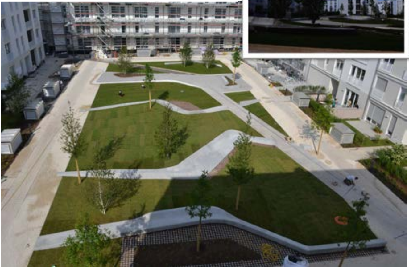
Frankfurt Riedberg – Innenhofgestaltung – Beton Sitz-, u. Liegeelemente
