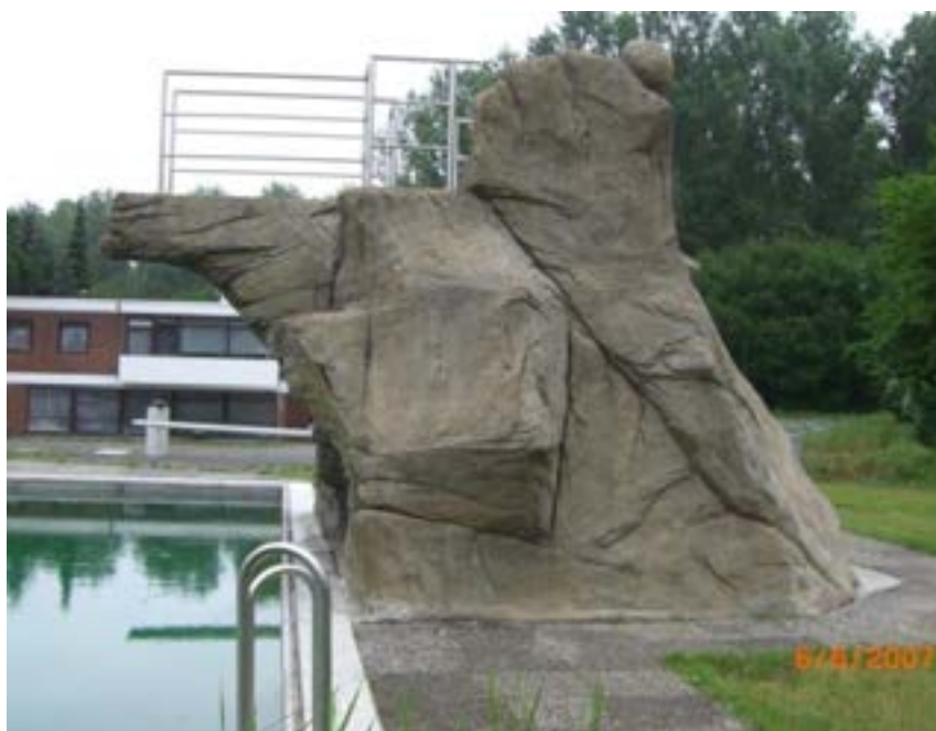
Freibad Bassum- Sprungberg aus Beton
